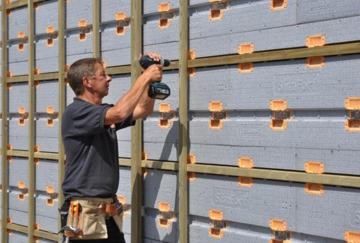
Mit dem neuartigen Dämmsystem IsoBouw Slimfort erhält der Verarbeiter ein besonders effektives Dämmelement mit integrierter, hochfester Konsole zur Aufnahme einer vorgehängten, hinterlüfteten Fassade
