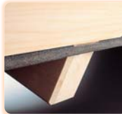
Trauböhrle mit Unterlage für den freien Wasserabfluss
