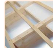
Detail Traufe mit Knagge (Schubholz)
