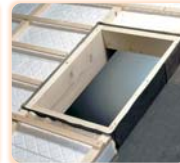
Problemlose Montage, z.B. bei Dachfenstern
